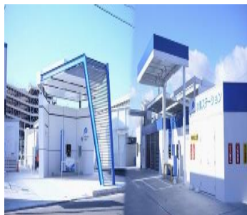
水素ステーション
